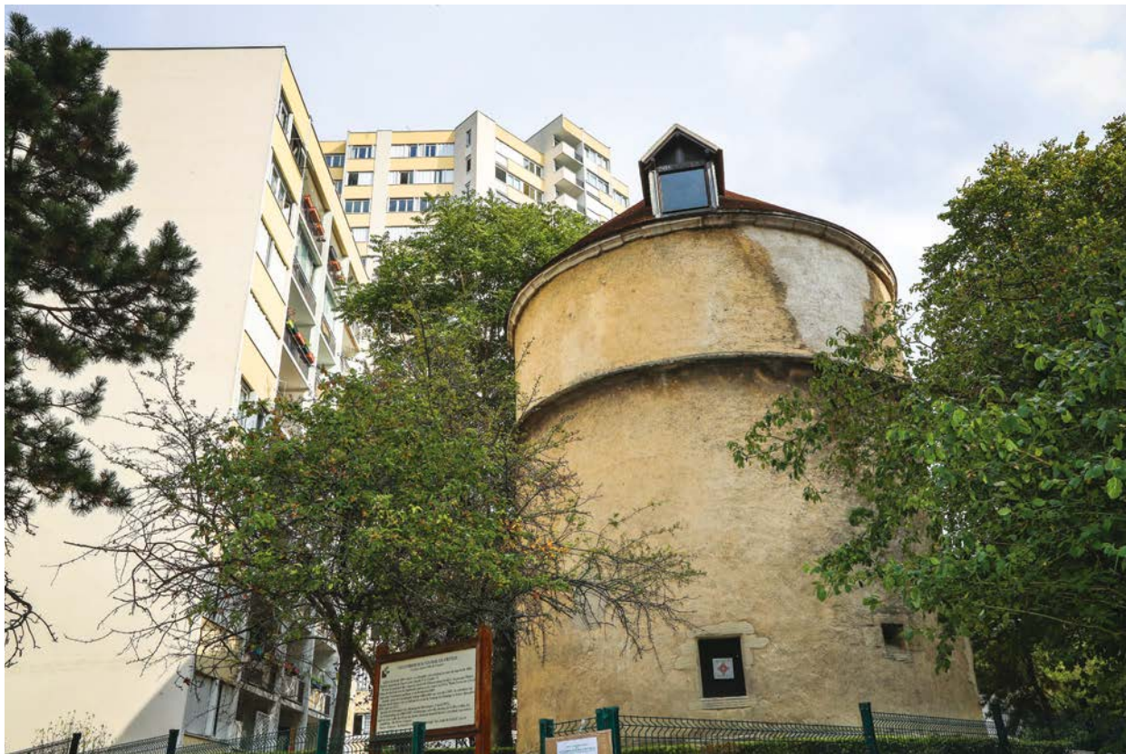
L'ensemble immobilier du Grand Colombier bénéficiera bientôt de cette énergie de chauffage plus propre et moins chère.
